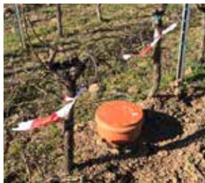
Saugkerze in einem Kunststoff- schutzschacht im Unterstockbereich
